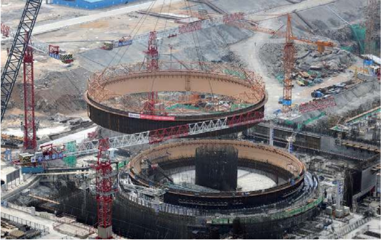
شكل توضيحي لمرحلة تنفيذ المحتوى الداخلي الأولي للهيكل الإنشائي المزدوج للمحطة النووية (كيرسك2) في روسيا
