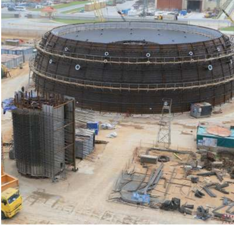
طريقة تنفيذ الخرسانة المسلحة لأحد المفاعلات
