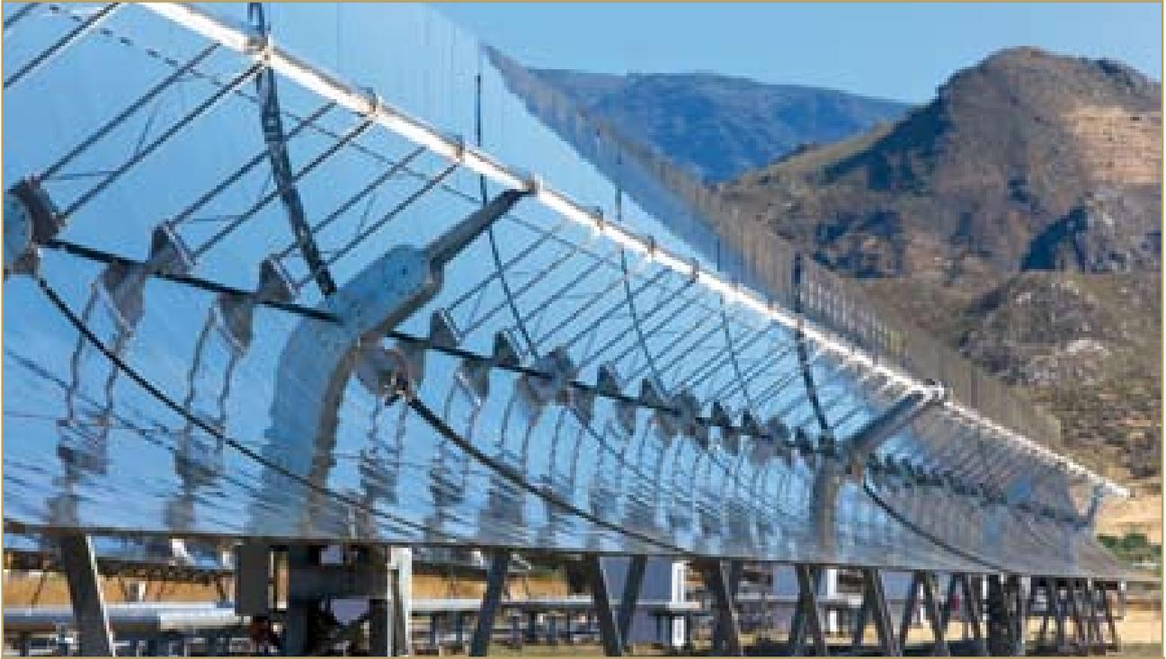
مجمع شمسي يستخدم القطع المكافئ ليعكس أشعة الشمس ويركزها على أنبوب ماص للحرارة على امتداد بؤرة القطع المكافئ فيسخن مائع التشغيل (زيت مركب) لينتقل الى مبادل حراري لتوليد البخار
