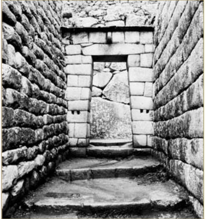
قوس البناء في ماتشو بيتشو يظهر تقنيات البناء التقليدية لدى الإنكا. بوابة بشكل شبه منحرف (واسعة في الجزء السفلي وضيقة في الأعلى) قوية وجميلة
