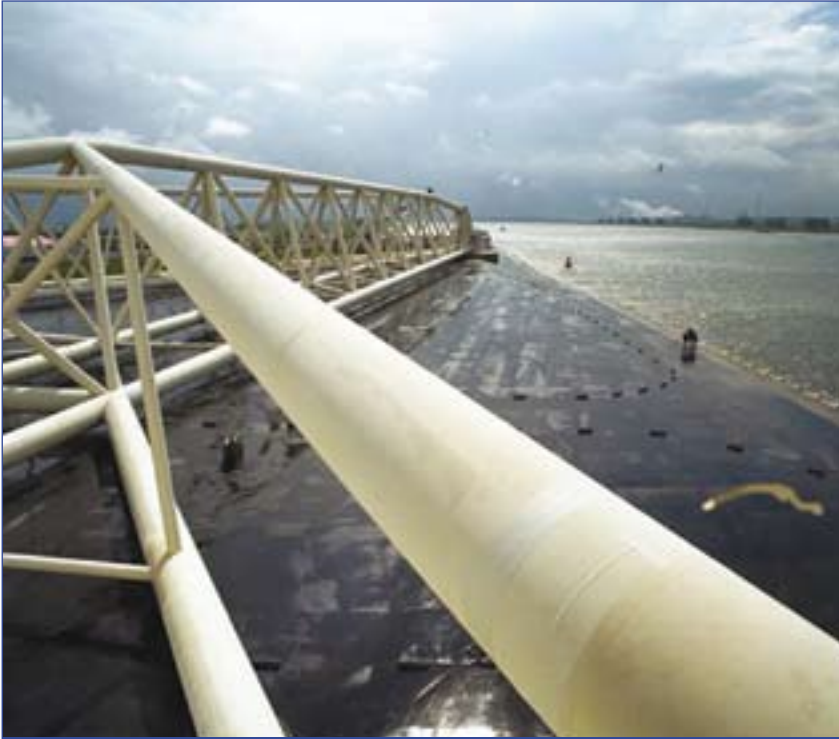
الرصيف المائي الذي يحجز السد عن الماء، إضافة إلى التروس الطويلة التي تساوي في طولها برج «إيفل»، في حين تم استخدام ضعف كمية الحديد التي احتاج إليها برج «إيفل» في بناء سد «مايسلانت كيرنغ» المتحرك
