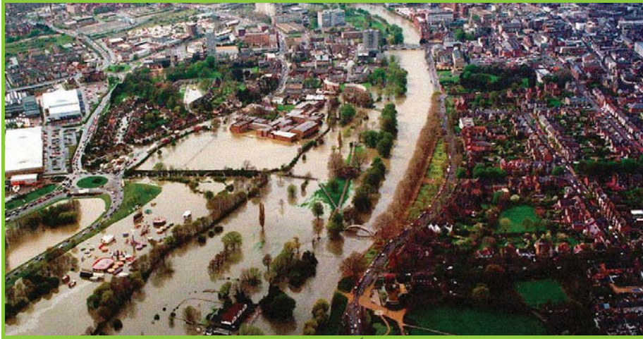
تحسين شبكة الصرف الصحي في المدن استباقاً لمثل هذه الكارثة
