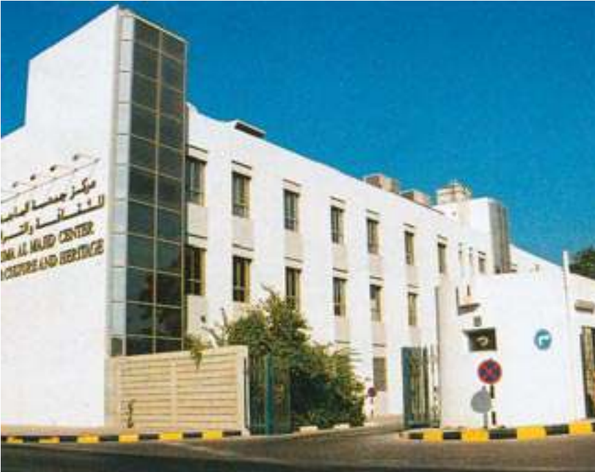
مبنى مركز جمعة الماجد
