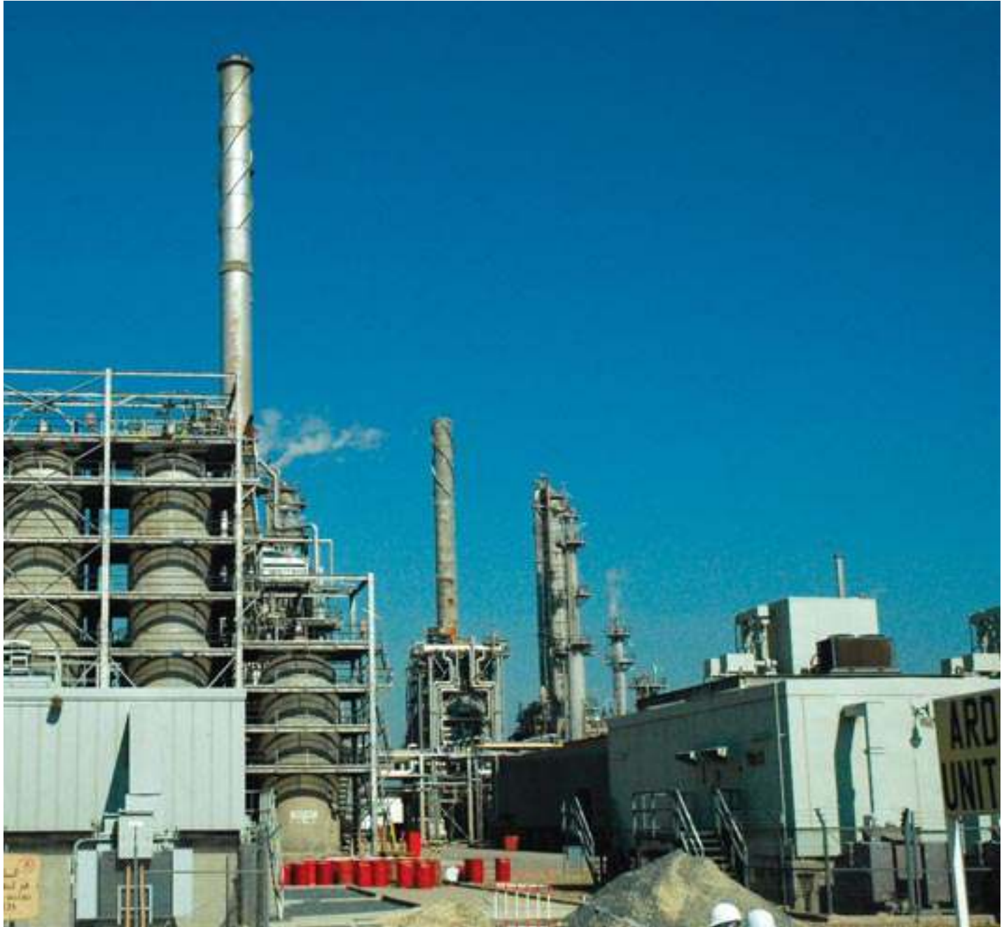
وحدة صناعية للمعالجة الهيدروجينية لمخلفات النفط لإزالة الكبريت، تعالج الوحدة نحو 33 ألف برميل في اليوم
