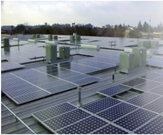
الشكل (4): توصل الخلايا الشمسية بعضها ببعض كوحدات وصفيفات تشكل منظومة متكاملة.
